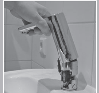
Armaturenoberteil vorsichtig nach oben abziehen.
