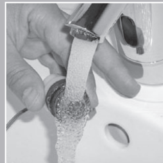
Bei starker Verunreinigung den Ventilfilter reinigen (ev. Zahnbürste verwenden) ggf. Ventil tauschen.
