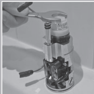
MV mit Schlüssel SW 17 vorsichtig öffnen. Das letzte Stück mit der Hand heraus-schrauben und entnehmen.
