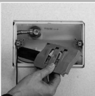
Lagerbock mit integriertem Motorheber herausnehmen und neuen einsetzen.
