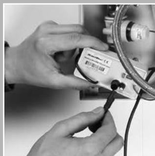
Sensorring am Elektronikmodul anschließen.
