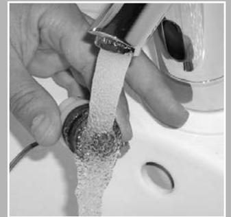
Bei starker Verunreinigung den Ventilfilter reinigen (ev. Zahnbürste verwenden) ggf. Ventil tauschen.
